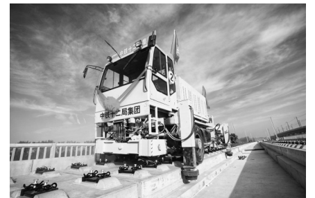
4月15日,北京至雄安城际铁路开始铺轨。图为当日,中铁十二局集团的建设者操作机械在京雄城际铁路李营段施工。
