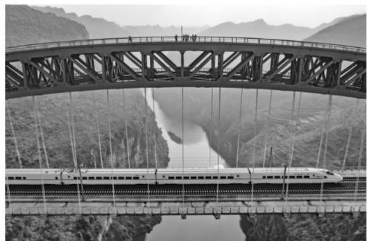
1月10日,贵阳高铁工务段工作人员在大桥上作业时,一列动车组正好经过。成贵高铁鸭池河特大桥横跨贵州省黔西境内的鸭池河,在地势险峻的峡谷间,每天约有100多组春运动车组穿行经过。在最高处距离河面约277米的大桥上,铁路职工坚守岗位,严格巡检,对大桥的钢结构、供电设备、桥梁支座、外包混凝土等进行细致检查,根据列车运行情况调整轨道线路的几何尺寸,进行钢轨探伤等作业,全力保障春运期间动车组安全通过。新华社记者 刘续 摄
