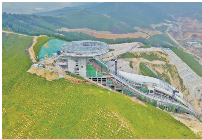
图为2020年7月30日拍摄的北京冬奥会张家口赛区的国家跳台滑雪中心“雪如意”项目工地。
